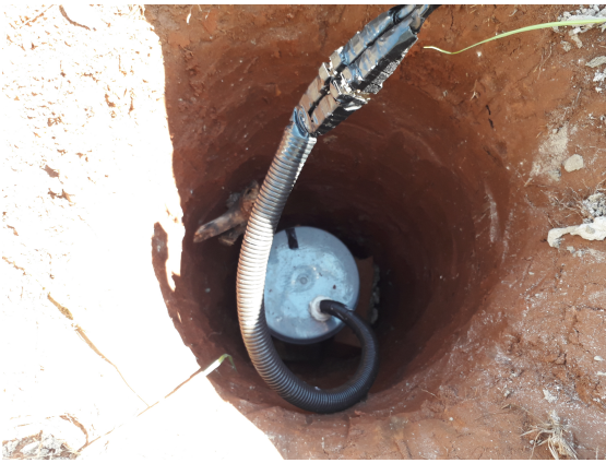
Fig. 17: Perforación de un Pozo de 1.10 m para la instalación de la unidad de recolección de datos. Fuente: [17].
