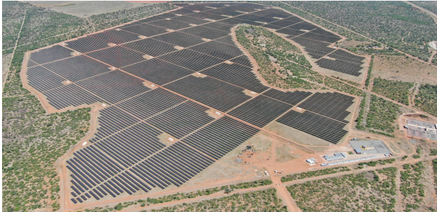
Figura 2. Planta fotovoltaica Tom Burke, Sudáfrica (66 MW). Fuente: [15].
